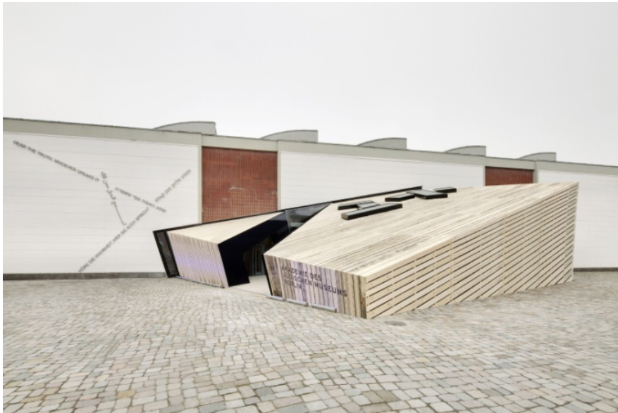
Außenansicht: Blick auf den Eingangskubus der W. Michael Blumenthal Akademie Architekt Daniel Libeskind AG, Zürich, Fotograf: Jan Bitter, Jüdisches Museum Berlin
