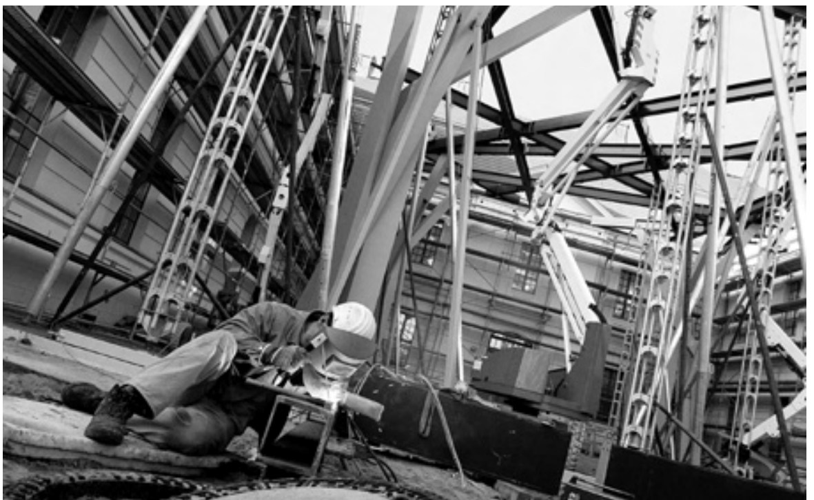
Schweißarbeiten an Stahlträgern
