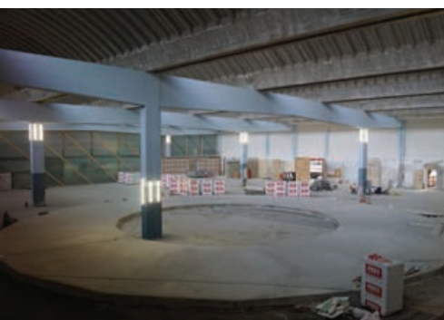
In der ehemaligen Blumengroßmarkthalle entsteht die ANOHA-Arche.
