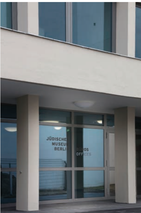
Der Eingang zu den Büroräumen im ehemaligen Blumengroßmarkt
